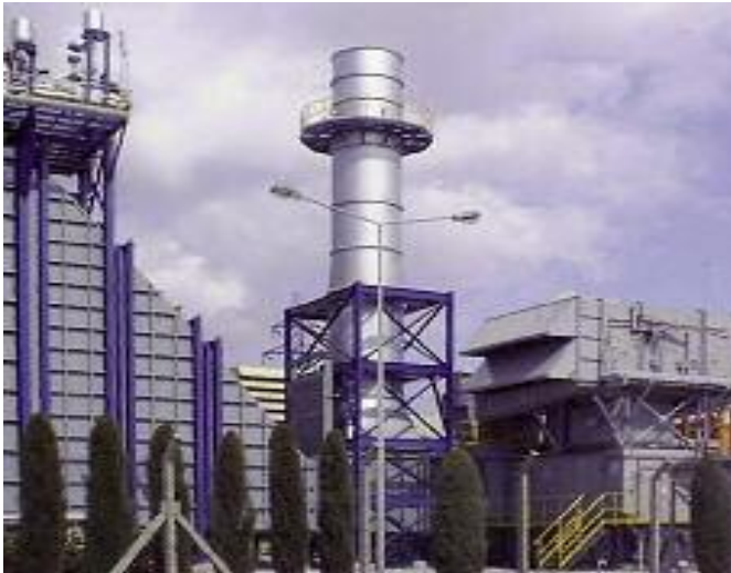
Das Bild oben zeigt die GUD-Anlage ENTEK in der Türkei mit dem kompletten Bypass-System.
