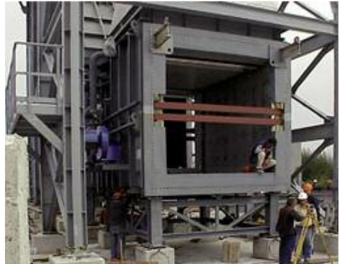
Montage eines DIVERTER mit Bypass-System unter einem Supervisor von RAUMAG-JANICH im GUD-Kraftwerk OSTIM in der Türkei.
