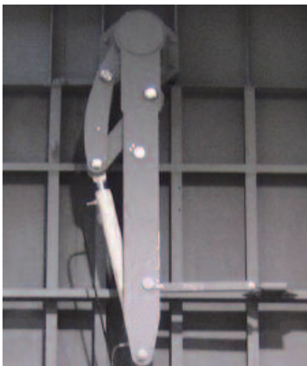
Bild unten: ZWEIHEBELANTRIEB an einer Gasweiche NW 5600 x 5600 mm
